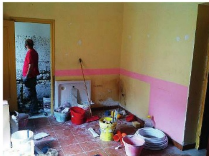
I lavori di ristrutturazione all'interno di uno degli appartamenti
